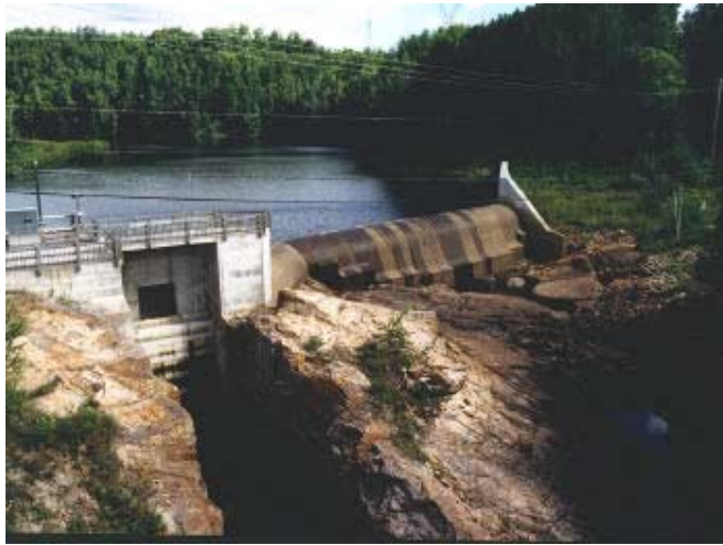
Barrage « au fil de l'eau » sur la rivière du Loup à Saint-Paulin
