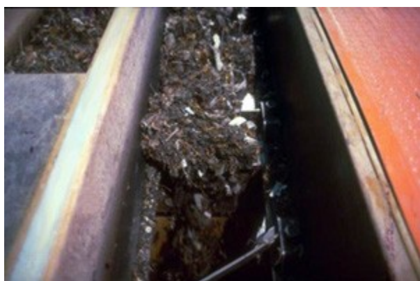
Résidus de grilles récupérés après le dégrillage
