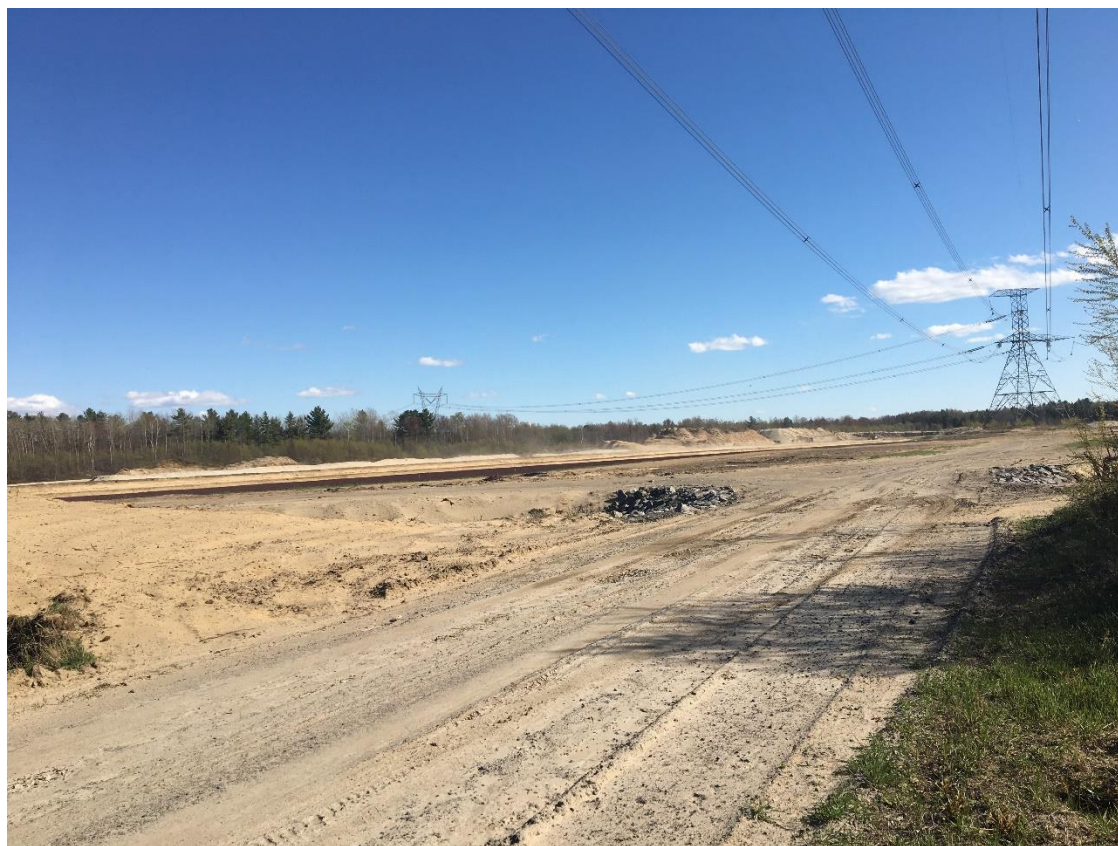
Figure 3 - Site de la cannebergère - Source : Eau Secours 2022
