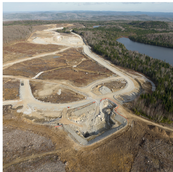
© COPH, Site minier Matawinie en construction
